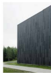
MAT04: GRC rainscreen cladding
